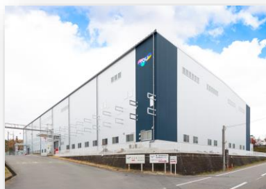
広化東リフロア新3号ライン
