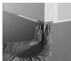
腰壁用出隅材の貼付け
