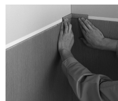
腰壁用入隅材の貼付け
