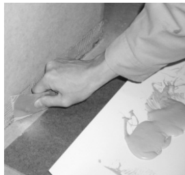
USセメント塗布 （巾木重ね貼り）
