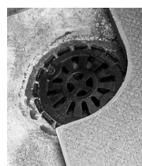
排水溝廻り（仕上がり例）
