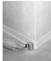
ソフト巾木の貼付け
