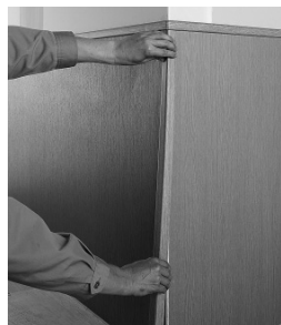
腰壁用コーナー材の貼付け
