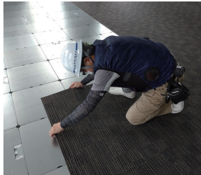
タイルカーペット施工の様子
