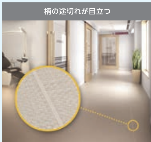
溶接棒を用いた一般的な継ぎ目処理
