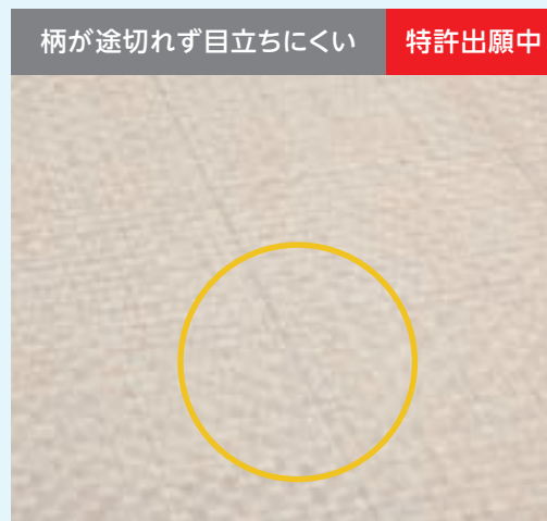
ジョイントシールドによる継ぎ目処理
