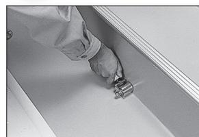
接着剤の貼付け可能時間内にシートを貼付けて蹴上げ上端をノンスリップ金物にのみ込ませ、圧着時間内にローラーで圧着します。
