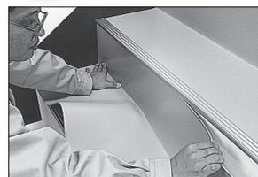
取合い部を曲げて、シート上端部をノンスリップ金物にのみ込まれるようにけがいて裁断します。シートが硬い場合はヒートガンなどで温めてください。
