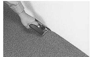
グリッパーと壁際の隙間がない時は、ステアツールを使って打込みます。写真のようにカーペットの端部をトリマーの爪ガイドで納めます。
