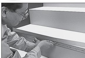
上部はノンスリップ金物にのみ込まれるように、直定規で裁断します。裁断後、接着剤を塗布してシートを貼付け、ハンドローラーで入念に圧着します。
