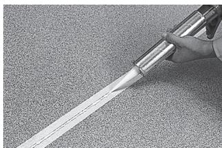
コーキングガンで継ぎ目部に底までしっかり充填します。
