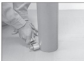
**6** 貼付け後30分以内にTローラー（タイルローラー）や3本ローラー（45kgローラー）などで十分に圧着します。
