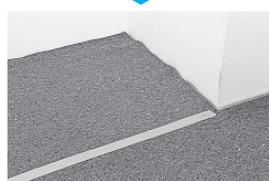
大面積の場合は、フェルトがずれないようにクラフトテープで継ぎ目部分を貼ると施工しやすくなります。
