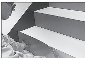
蹴上げの寸法を測り、実寸より若干大きめに粗切りします。カットした材料が混ざらないように、貼付ける順番に並べておくと良いでしょう。
