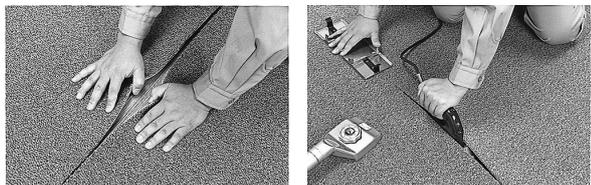
引き伸ばし作業後、ジョイントの真下にテープの中央がくるようにシーミングテープをいれます。
