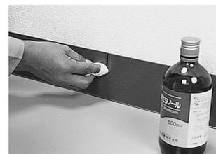
硬化した接着剤は鋭利な刃物で大方を削り取り、残りを水またはアルコールで軽くぬぐうようにして取除きます。
