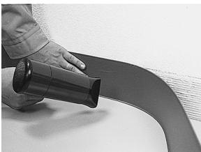
入隅部の貼付け後、次の巾木を順々に突付けて、床の不陸になじませながら、充分圧着して貼付けます。ケース単位で順々にカット面を突き合わせるように貼ります。巾木と床面に隙間ができるようなら、ドライヤーなどで巾木を温めてなじませてください。
