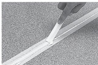
充填後、すぐに仕上げ用のヘラで表面を平滑に仕上げます。
