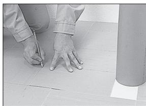
切込みを行うタイルを一枚手前のタイルの上に正確にのせ、印を付けます。パイプの手前、奥、左右などを採寸して、同様に一枚手前のタイルに正確にのせ印を付けます。印をつないでカッターで切ります。
