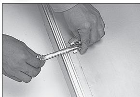
蹴込みに沿ってけがき、裁断し、両サイドは蹴込みと同様にけがき、裁断します。ノンスリップ部は、落とし込みで裁断します。裁断後、接着剤を塗布してシートを圧着します。
